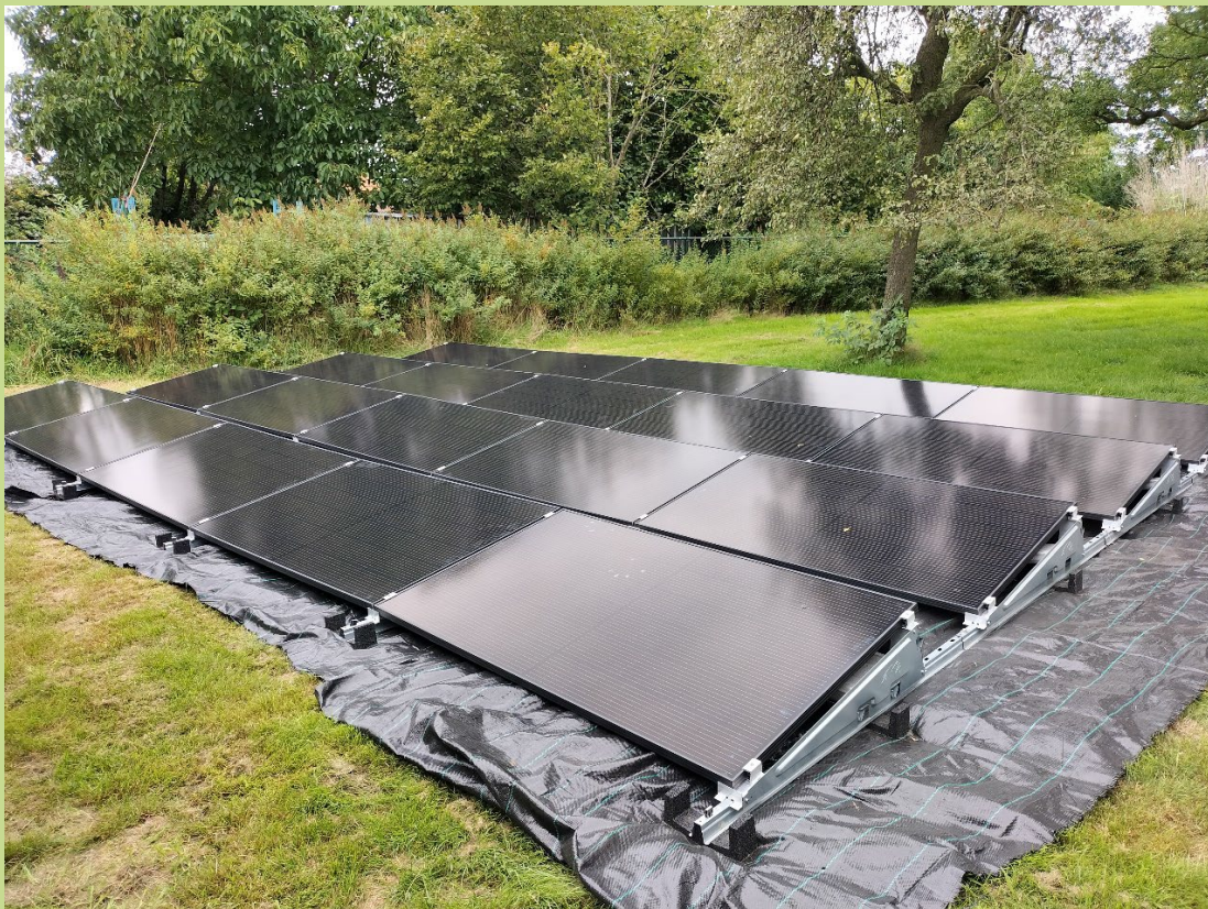
De zonnepanelen zijn geplaatst op 16 augustus 2023.
